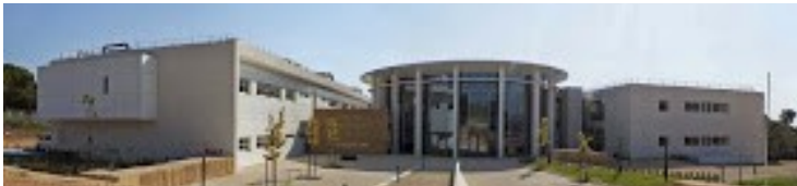
Vue extérieure de l'ISCM
